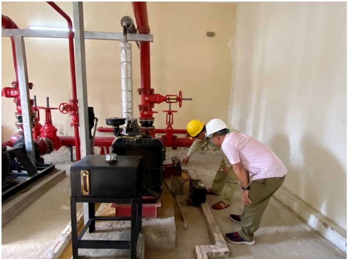
Kiểm tra hệ thống Phòng cháy chữa cháy
