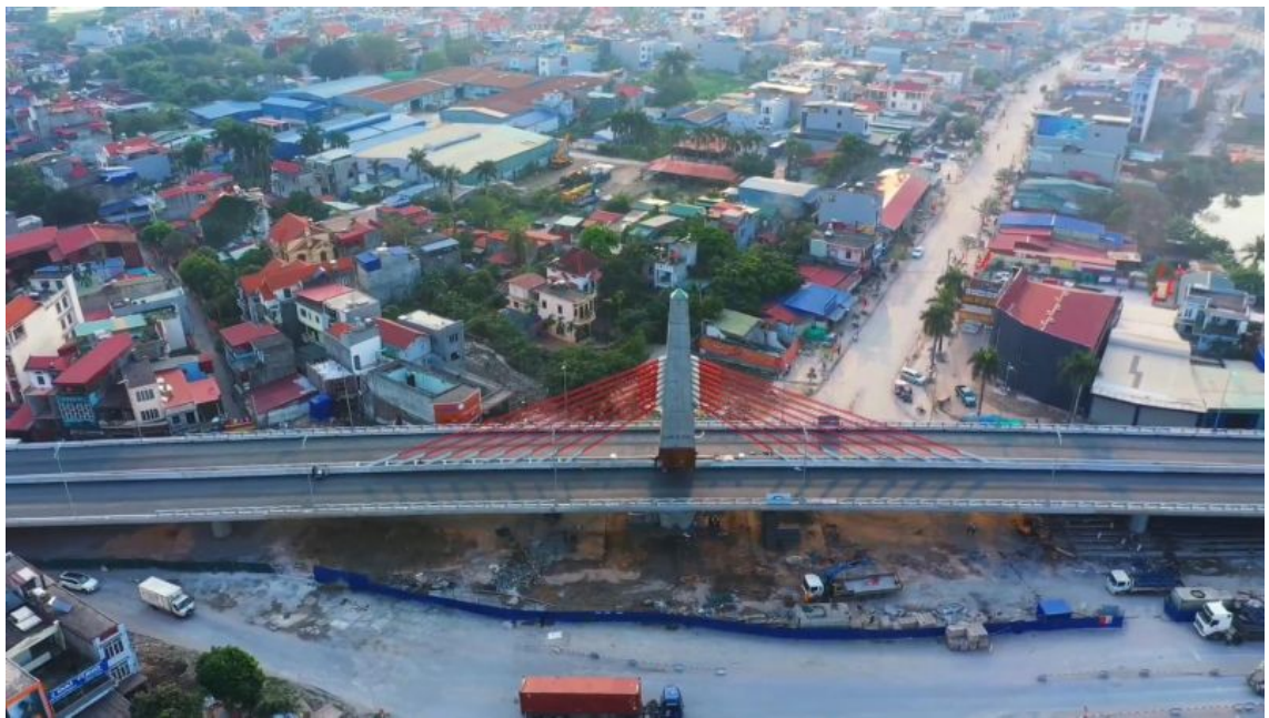
Cầu Vượt nút giao Cơ điện TP. Hải Phòng
