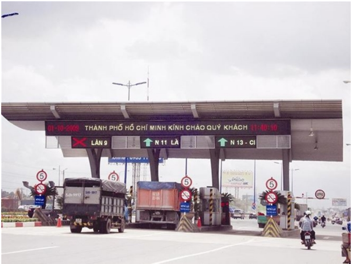
Trạm thu phí cầu Phú Mỹ
