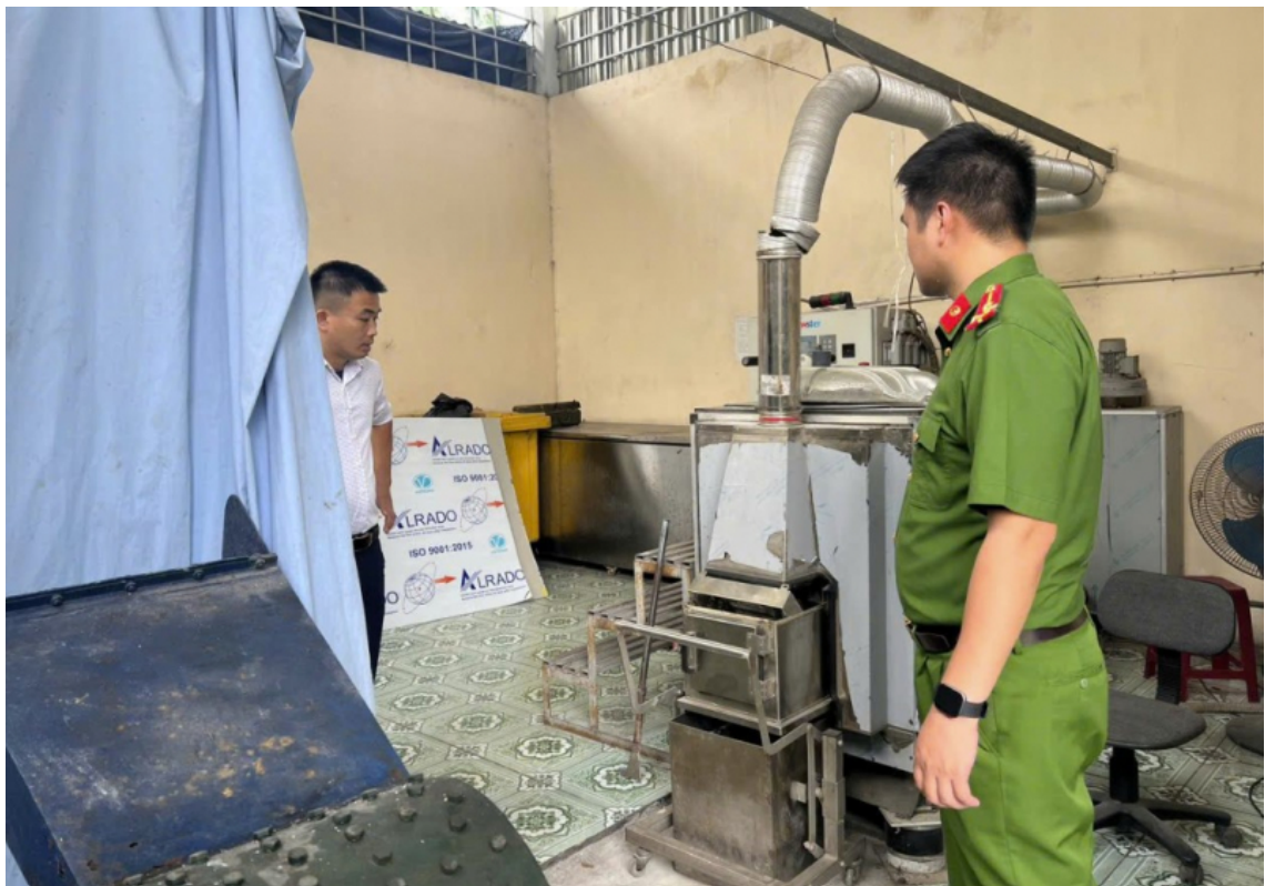
Lực lượng chức năng kiểm tra hệ thống xử lý chất thải tại Bệnh viện Phổi Tuyên Quang. (Ảnh: Công an tỉnh Tuyên Quang)
