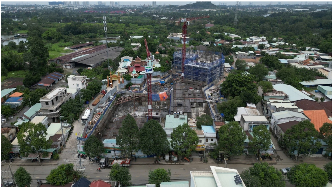
Toàn cảnh tiến độ thực tế dự án Fresia Riverside – Dấu ấn thi công đảm bảo tiến độ, chuẩn bị cho hành trình bàn giao chất lượng
