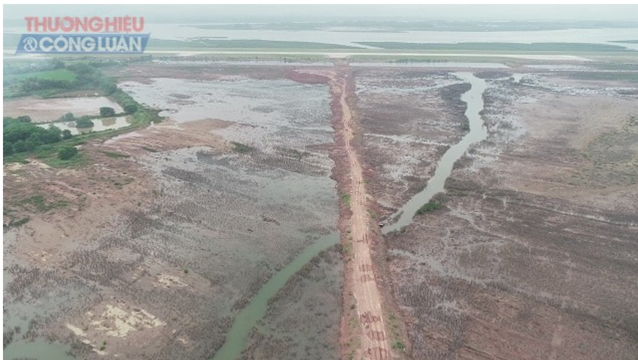
Toàn bộ cánh rừng ngập mặn bị đường chở đất công vụ cắt ngang, chặn dòng thủy triều lên xuống
