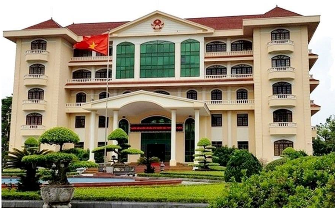
Trụ sở UBND tỉnh Ninh Bình
