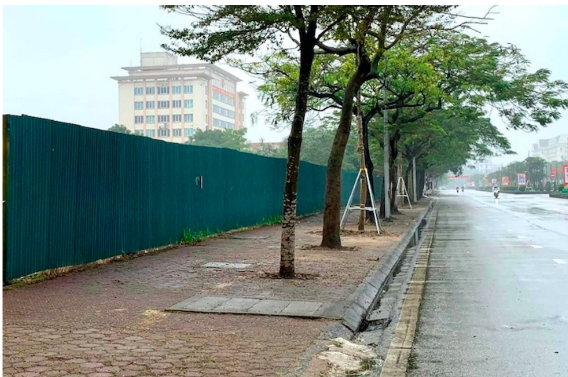
Khu đất thực hiện Dự án Khu khách sạn và Nhà chung cư hỗn hợp thuộc Khu hành chính tập trung tỉnh Hải Dương
