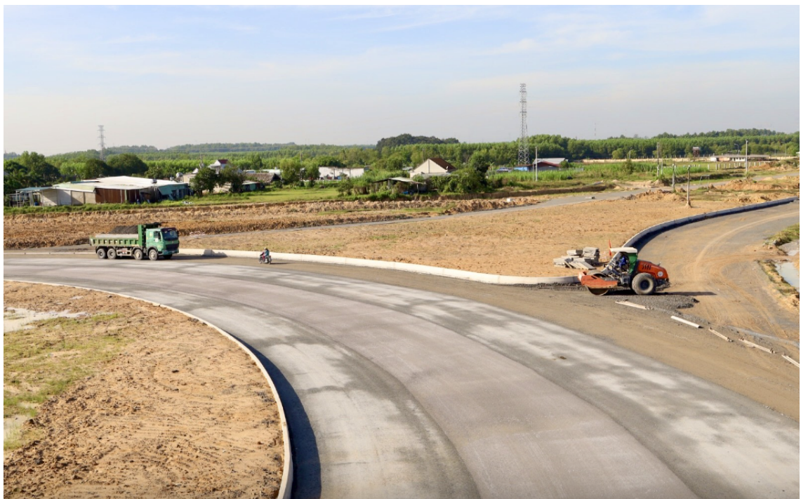
Khu vực thi công đường Vành đai 3 TP. HCM đoạn qua Đồng Nai. (Ảnh: Ngọc Quý)
