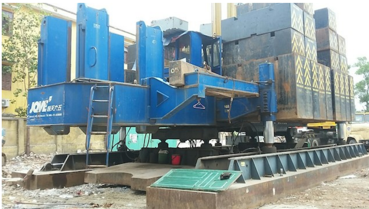
Máy ép cọc của đơn vị thi công hoạt động gây rung lắc, rất nguy hiểm cho an toàn khu nhà Đ10 Đồng Quốc Bình (Ảnh: PV)
