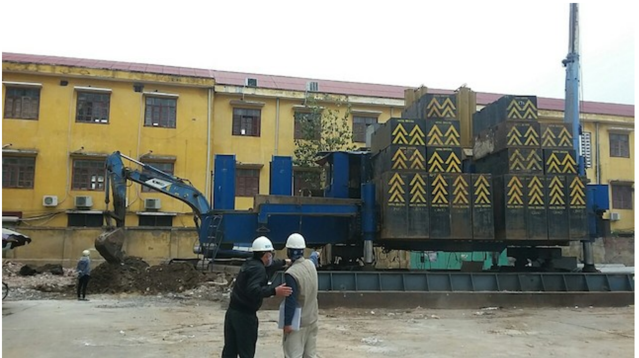
Nhà trường cho máy ép cọc của đơn vị thi công đến đào cuốc đất tại khuôn viên khu nhà Đ10 Đồng Quốc Bình (Ảnh: PV)
