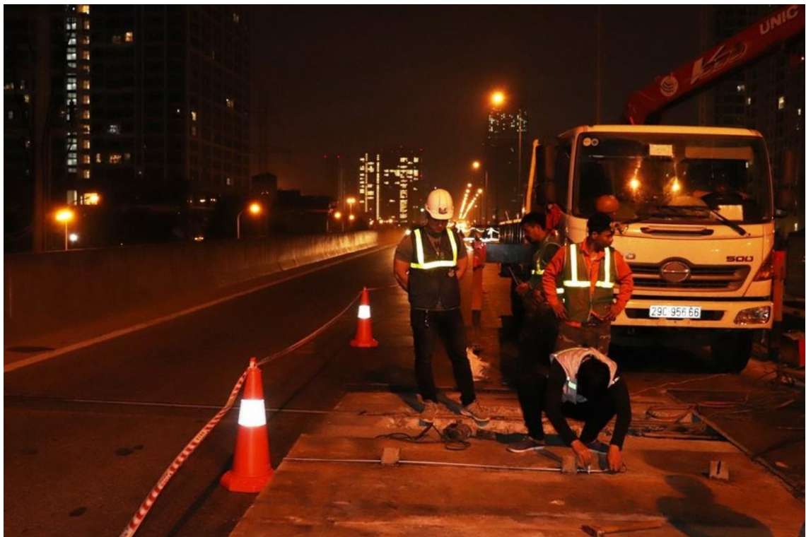
Công nhân rào chắn đường vành đai 3 để sửa chữa khe co giãn
