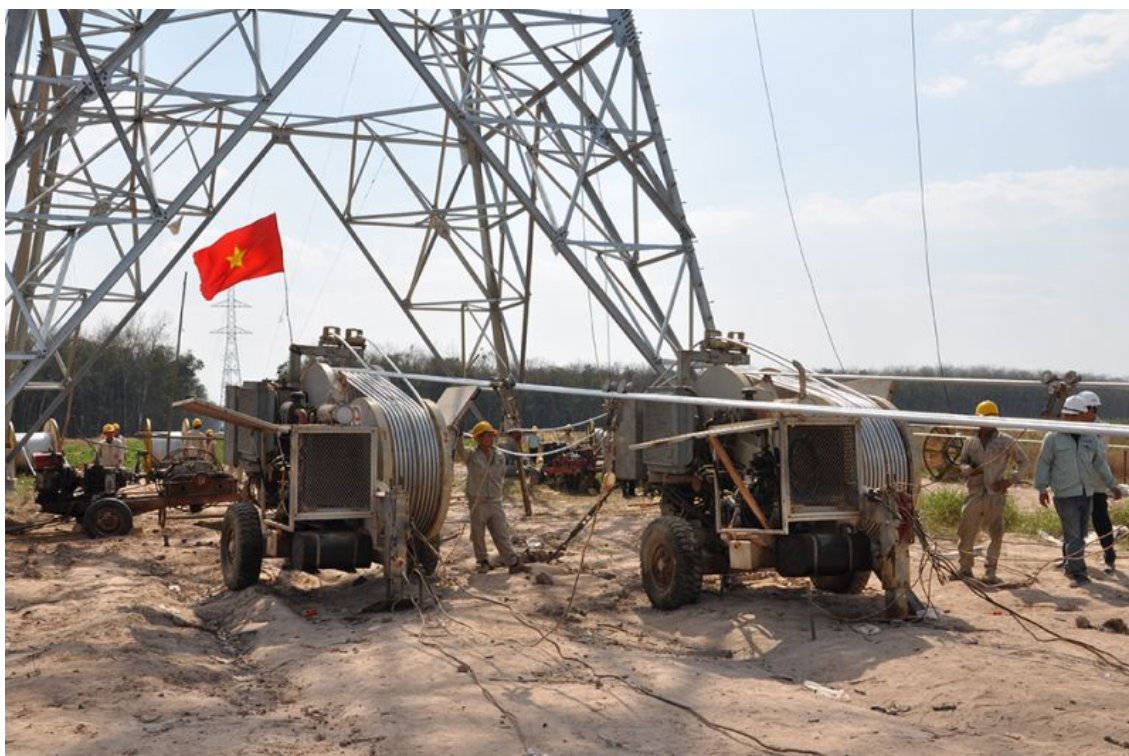
Vượt nắng, thắng mưa thi công dựng cột, kéo dây đường dây 500kV mạch 3 -Ảnh:VGP/ Toàn Thắng
