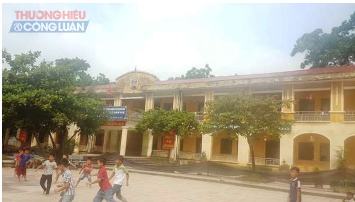
Toàn bộ phần mái đã thi công xong
