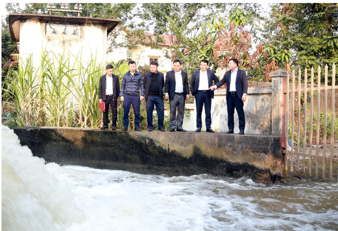
Phó Chủ tịch Thường trực UBND tỉnh Vũ Việt Văn kiểm tra công tác lấy nước đợt 1 tại trạm bơm Quán Bạc, xã Nguyệt Đức (Yên Lạc)
