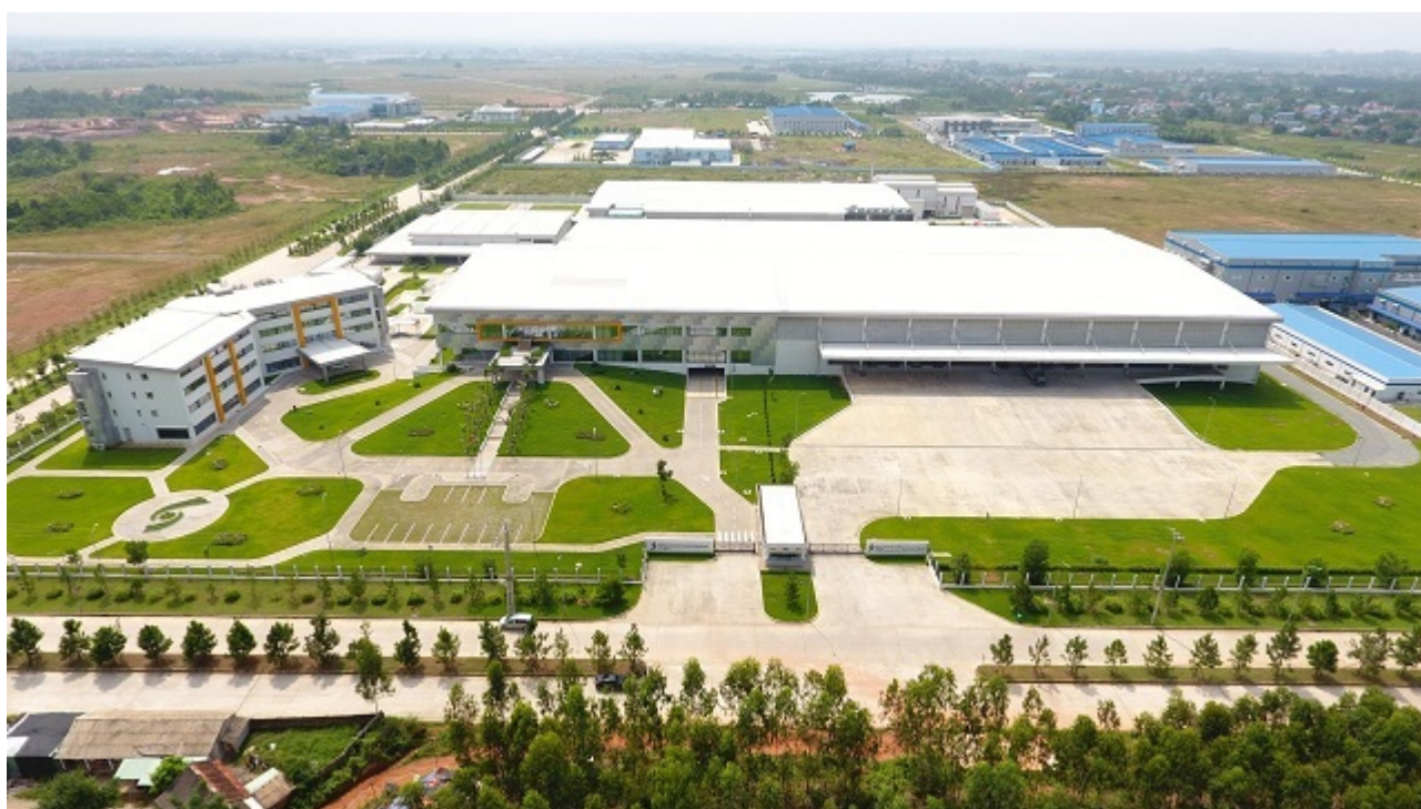
Khu công nghiệp Bá Thiện II nhìn từ trên cao
