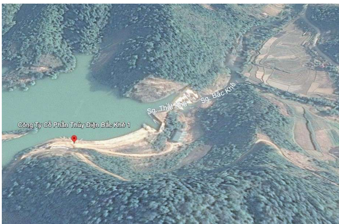
Vị trí đập Bắc Khê. Ảnh Google Earth
