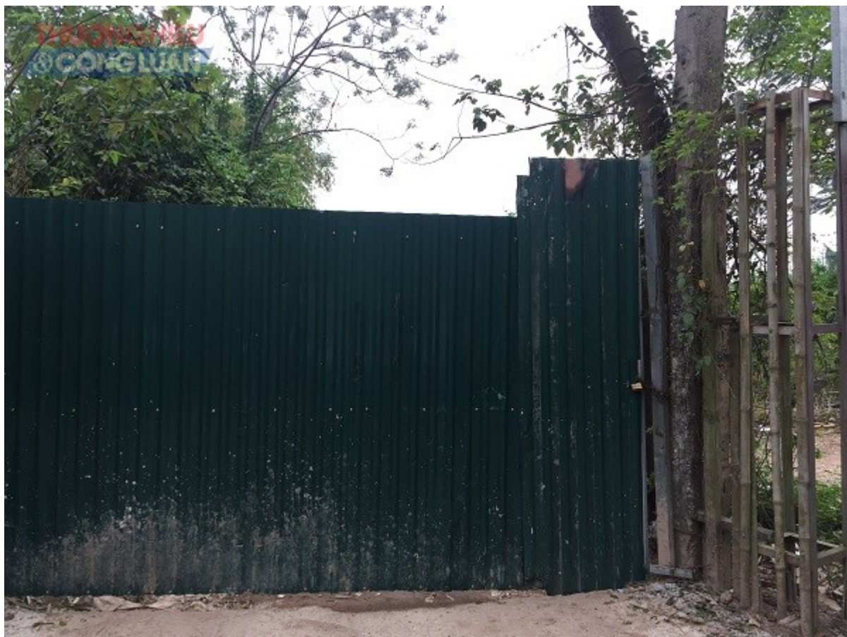
Lối ra vào khu vực bờ sông Hồng đã được rào kín bằng tôn
