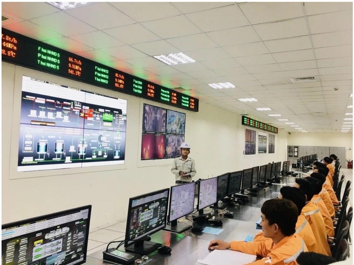
Hiện các nhà máy nhiệt điện của Hòa Phát giúp tập đoàn chủ động khoảng 90% nhu cầu điện sản xuất thép. Ảnh: HPG.
