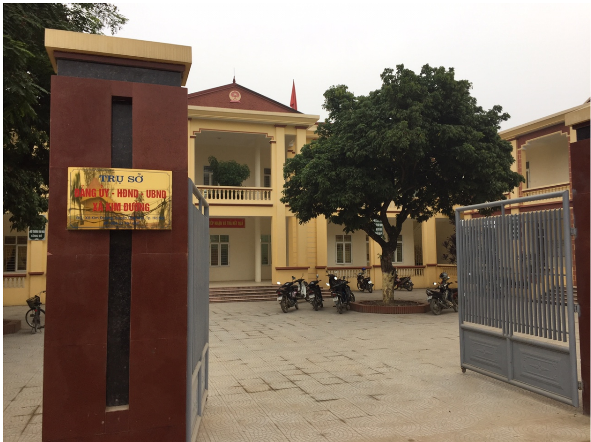
Trụ sở UBND xã Kim Đường (Huyện Ứng Hoà, Hà Nội)
