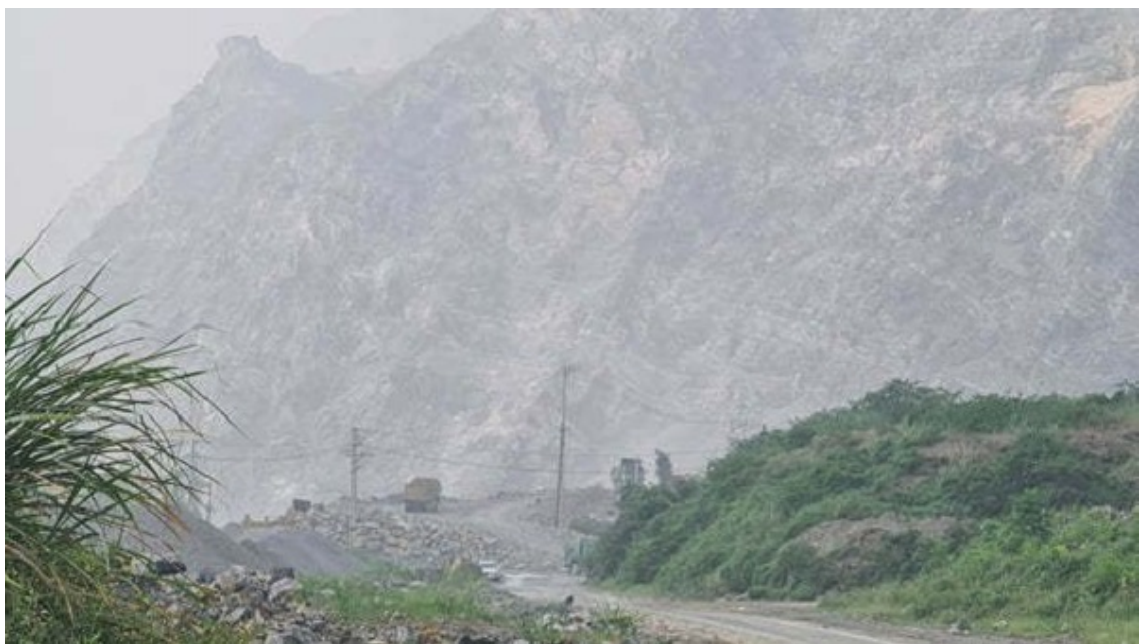
Khu vực xảy ra vụ sập mỏ đá
