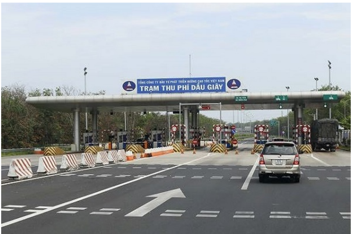
Trạm thu phí Dầu Giây nơi vừa xảy ra vụ cướp
