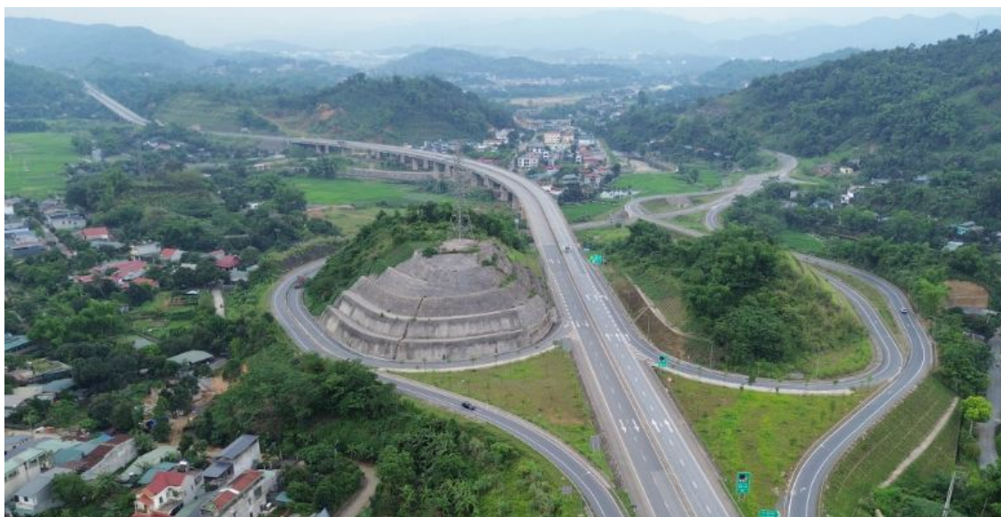
Cao tốc Nội Bài - Lào Cai đoạn từ nút giao IC18 đến cửa khẩu Kim Thành.
