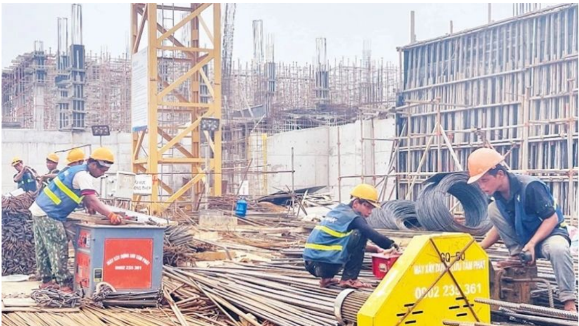
Dự án Trung tâm hội nghị tỉnh Yên Bái đang được đẩy nhanh tiến độ thi công (Ảnh: Báo Nhân dân)
