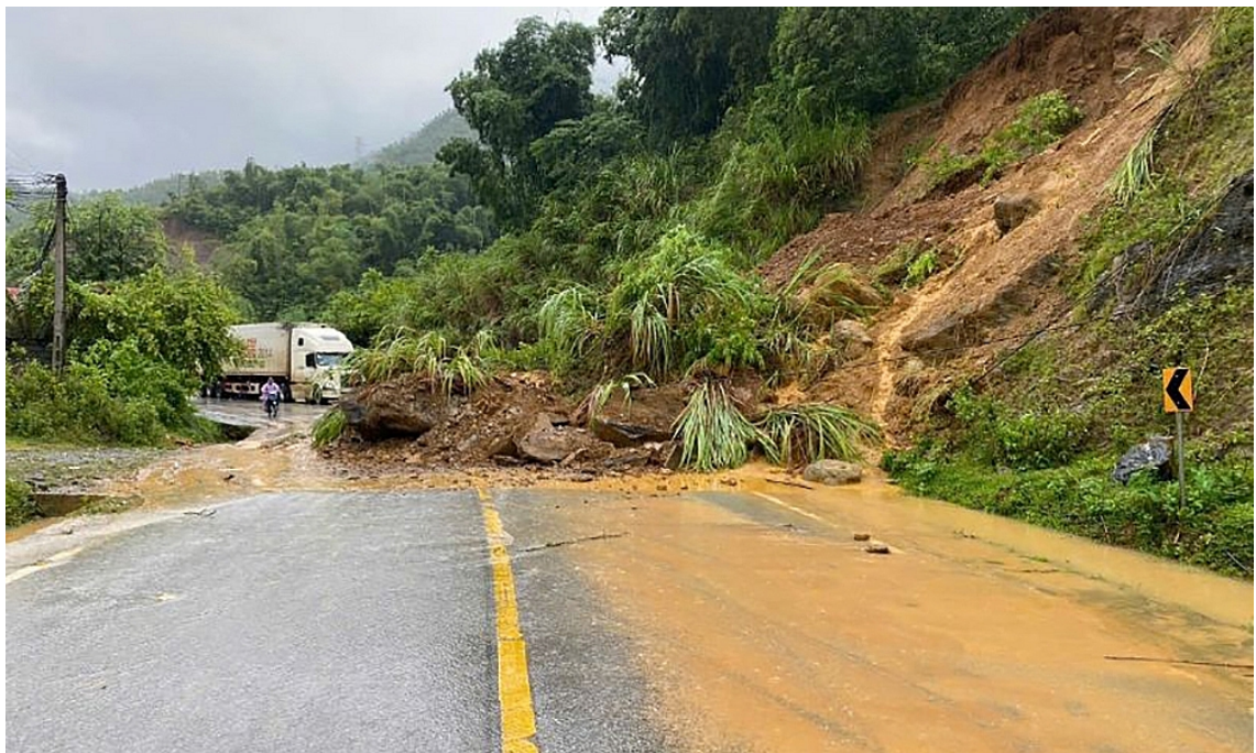
Yêu cầu rà soát toàn bộ cầu, hạ tầng giao thông vùng ảnh hưởng bão. Ảnh internet.
